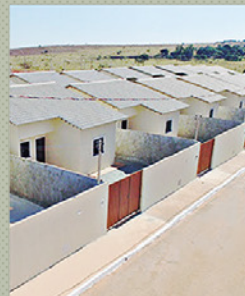
Residencial Boa Vista - Casas
