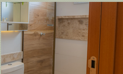
Nicho em mármore Bege Bahia nos banheiros.
