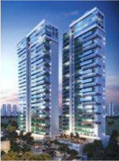
PARQUE DA TIJUCA EURO PARK | EM ANDAMENTO UNIDADES: 170 | ÁREA: 45.886,97 M² GOIÂNIA - GO
