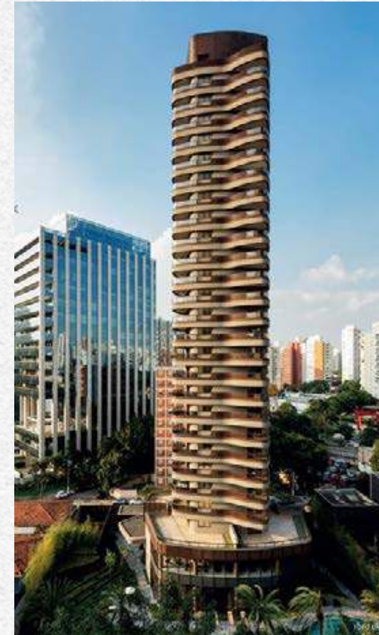
CYRELA BY PINIFARINA FOTO DA OBRA CONCLUÍDA (2020)
