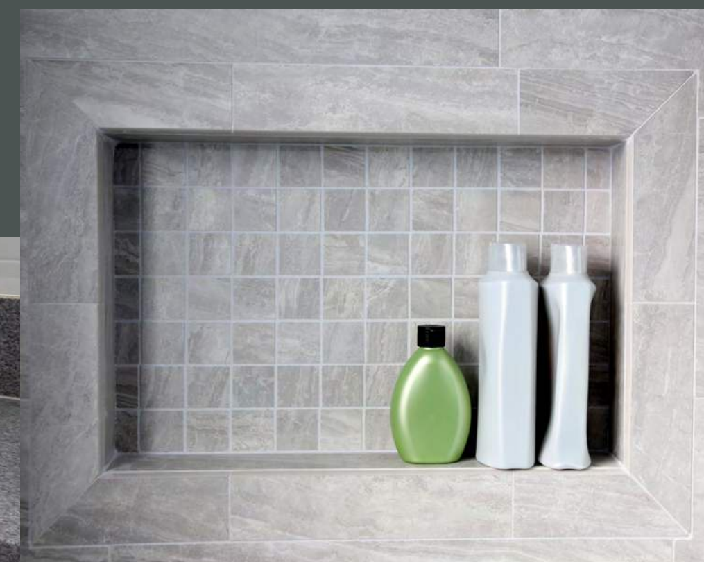
Nicho para o box do banheiro em porcelanato
