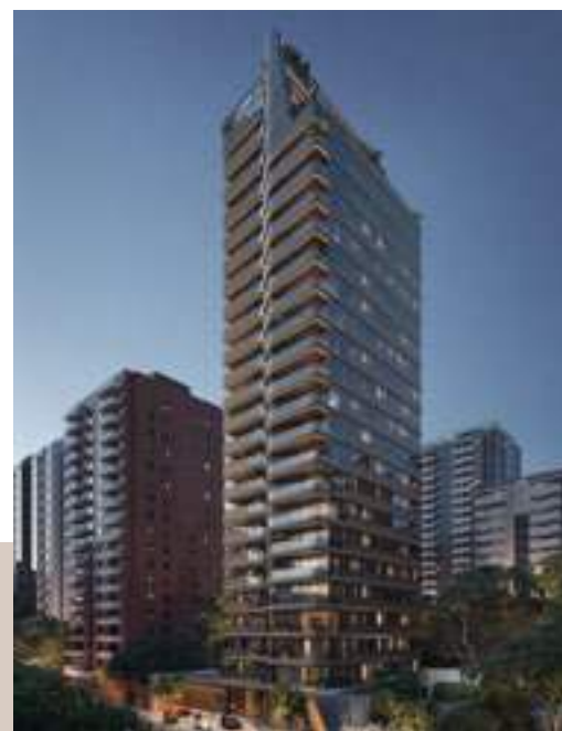
TORRE CARRA CIDADE DA GUATEMALA, GUATEMALA
