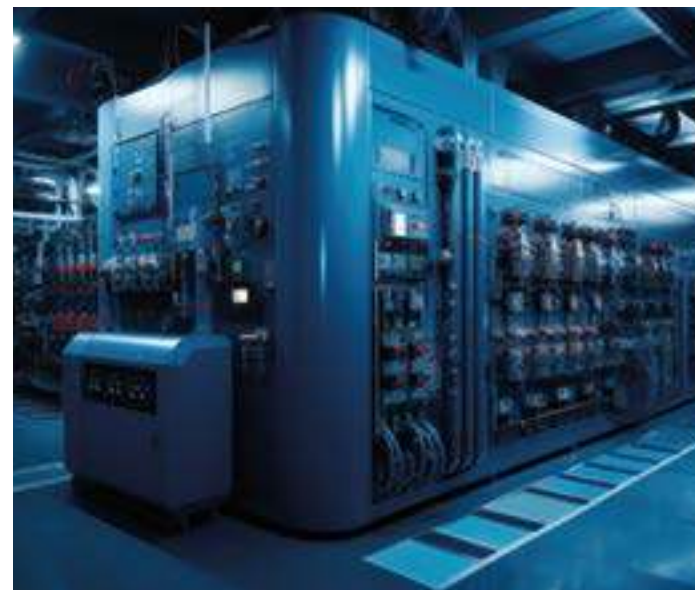
Gerador em 100% do empreendimento*
