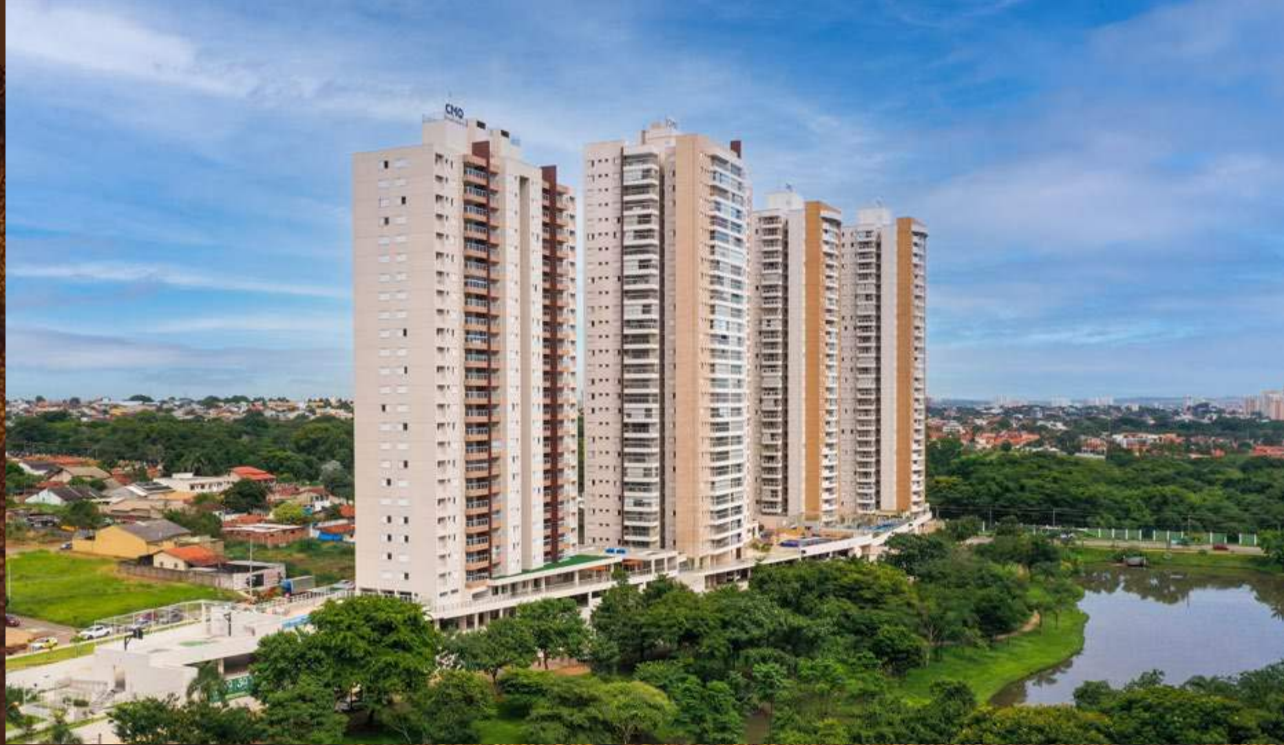
Varandas de Copacabana, Varandas de Ipanema e Varandas do Parque
