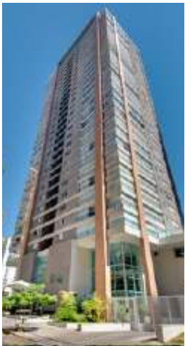
TORRE DEL PARC
