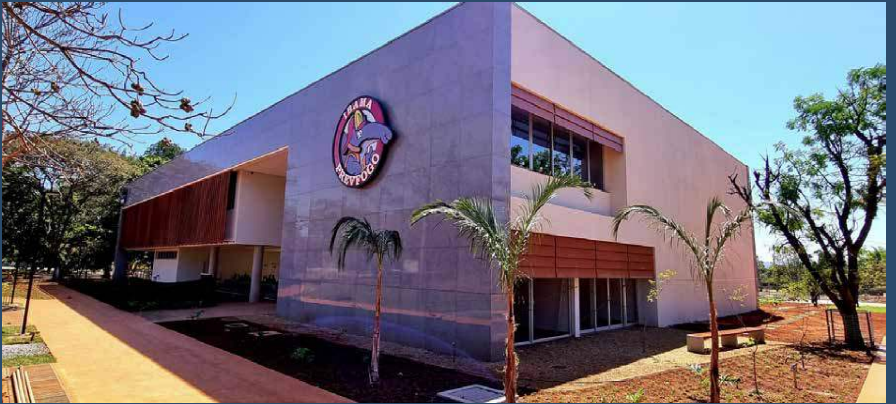
CONSTRUÇÃO PREDIO PREVFOGO IBAMA BRASÍLIA
