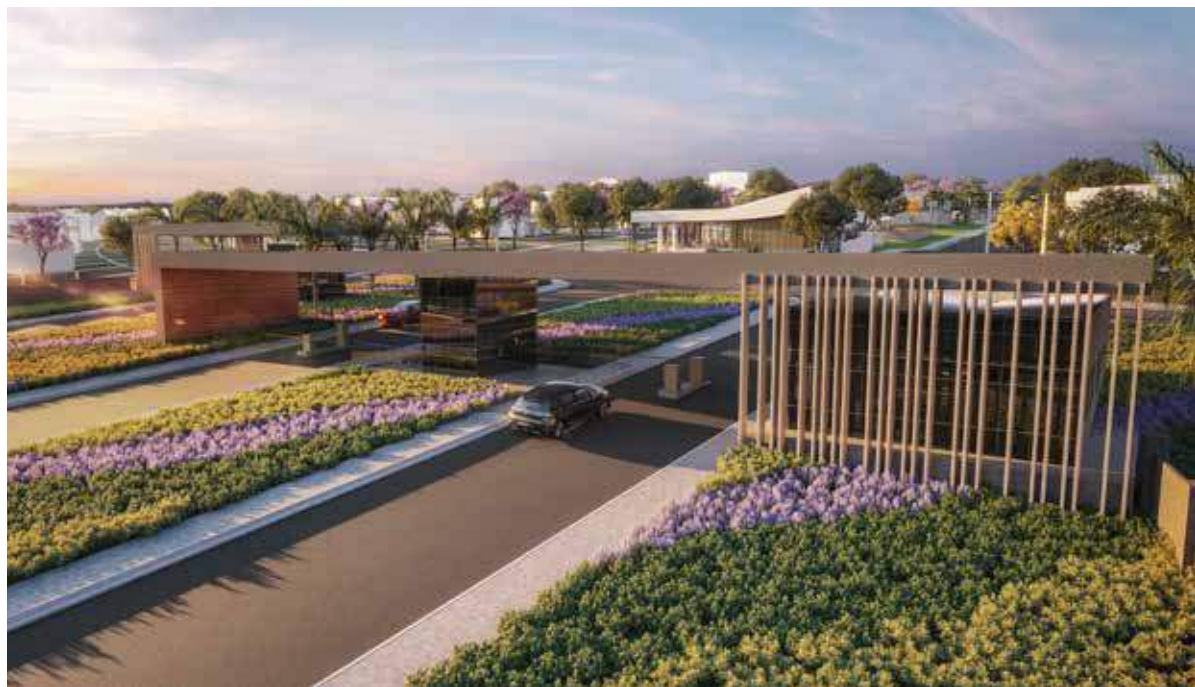
CONDOMÍNIO HORIZONTAL ENTRE RIOS
