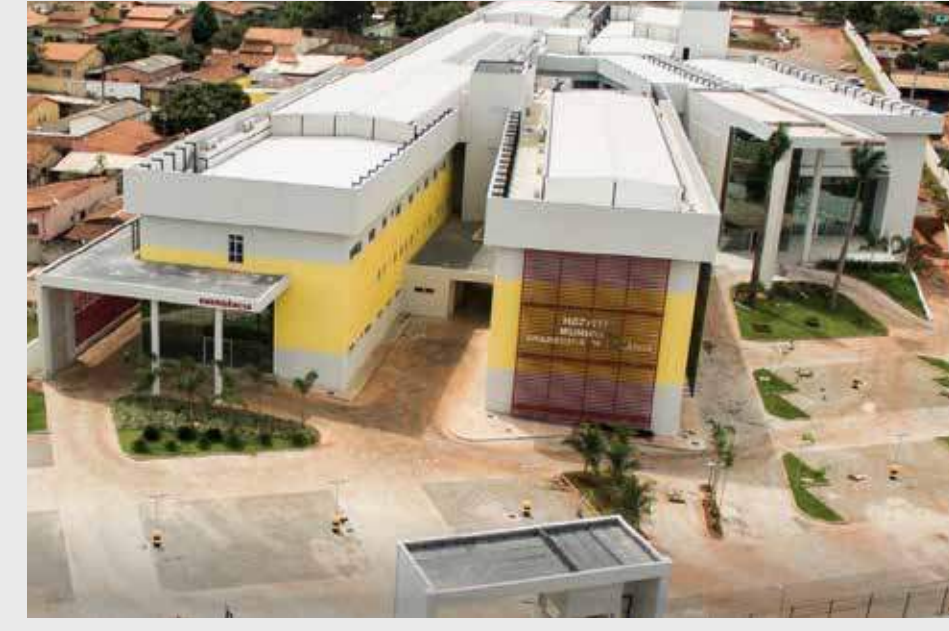
CONSTRUÇÃO | HOSPITAL MUNICIPAL DE APARECIDA DE GOIÂNIA.(GO)
