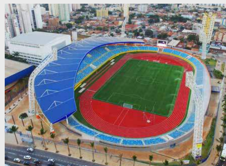
CONSTRUÇÃO | ESTÁDIO OLÍMPICO (GO)
