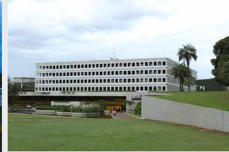
RETROFIT | SEDE DO TRIBUNAL DE CONTAS DA UNIÃO (DF)
