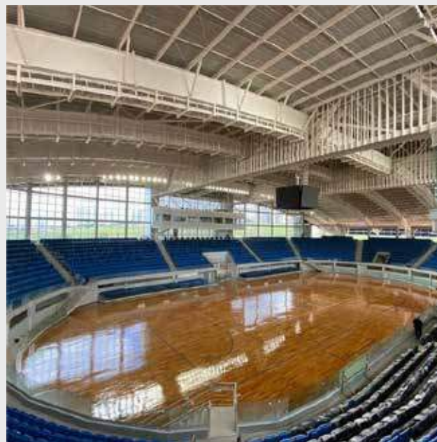
CONSTRUÇÃO | ARENA MUNICIPAL DE ESPORTES (SP)
