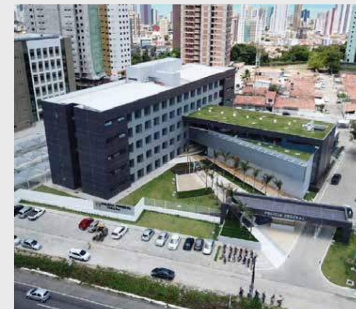
CONSTRUÇÃO | SUPERINTENDÊNCIA DA POLICIA FEDERAL (PB)
