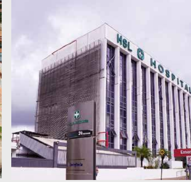
CONSTRUÇÃO | HOSPITAL SANTA LUZIA (DF)
