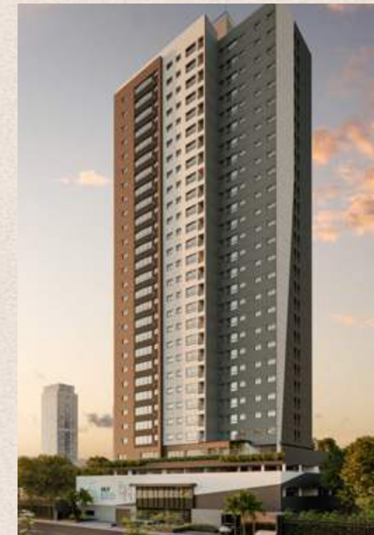
Muy Bueno Condomínio Vertical
