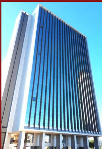
CAIXA ECONÔMICA FEDERAL - DF
